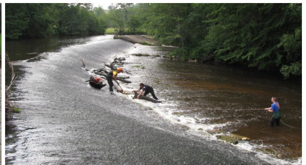
Intervention de la régie sur le seuil du moulin de Chabrot
