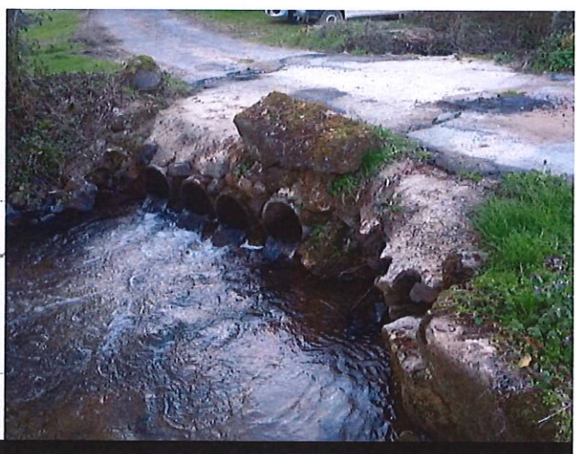
Buses sous-dimensionnées (obstacle continuité écologique)
