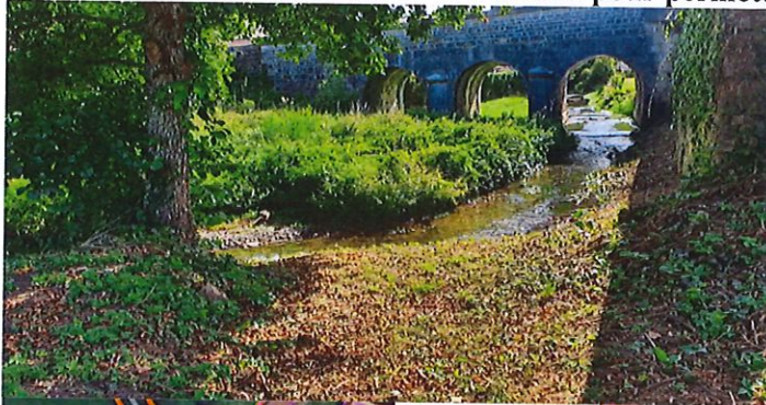
Figure 1 : Encombrement du pont par plus de matériaux
