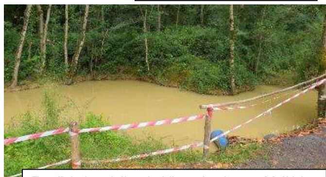
Figure 49 : bassin pour la décantation de l'eau au niveau des travaux de la déviation
