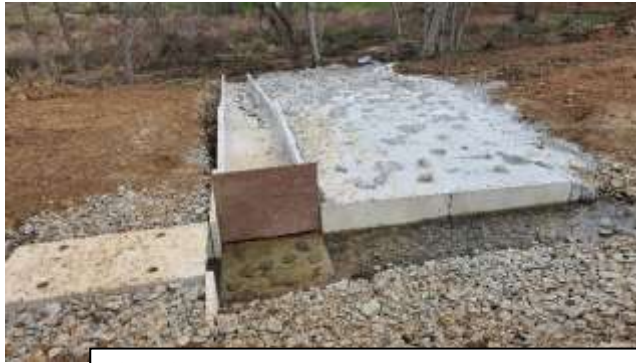
Figure 74 : répartition entre la rivière de contournement et l'étang aval
